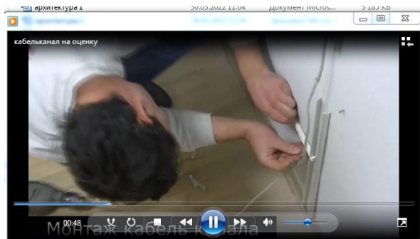
Рисунок 1- Окно видеоролика с производства- укладка кабель-канала
